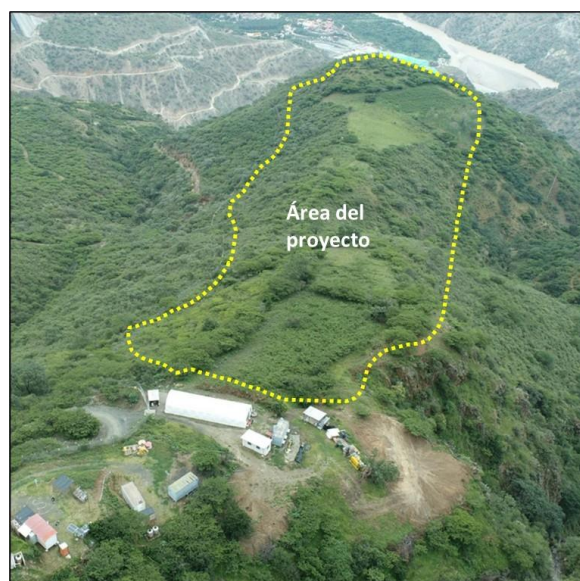
Fig. 09 Ubicación del sistema solar fotovoltaico
