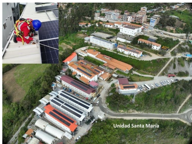
Fig. 08 Paneles fotovoltaicos en Santa María
